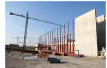
+ Imatge d'arxiu de les obres a la plaça Major. Foto: M.C.
